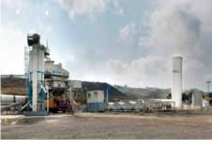
Aygaz Doğal Gaz LNG müşteri sahası
