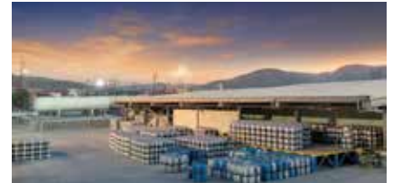
Işıkent Dolum Tesisi
